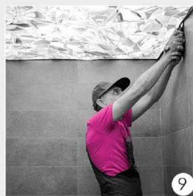
نصب سقف با استفاده از ابزار مخصوص
