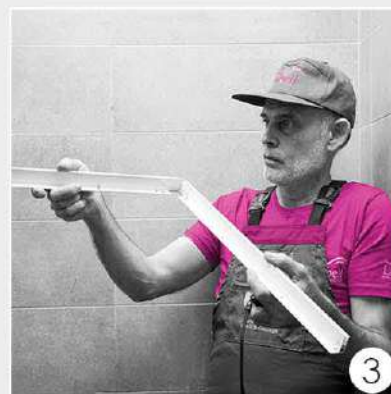
برشکاری، خمکاری و سوراخ کردن پروفیل
